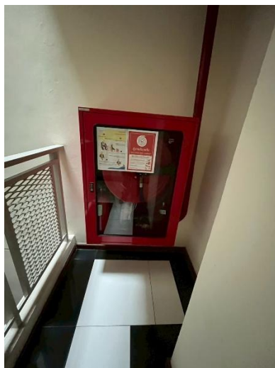
ภาพที่ 33 ตู้เก็บอุปกรณ์ดับเพลิง
